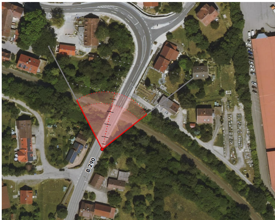
Bild: Standort des Zählgerätes mit Ausrichtung
